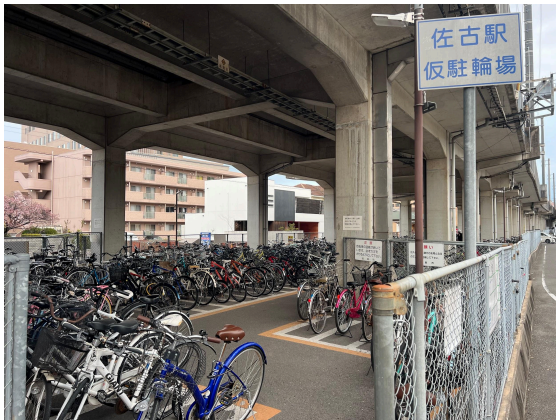
図3 佐古駅高架下駐輪場
