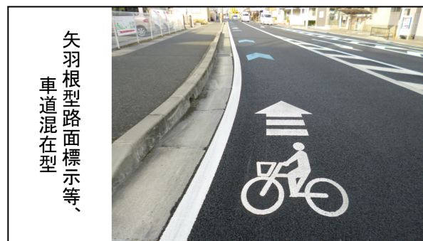
図8.矢羽根型路面表示等、車道混在型 [8]
